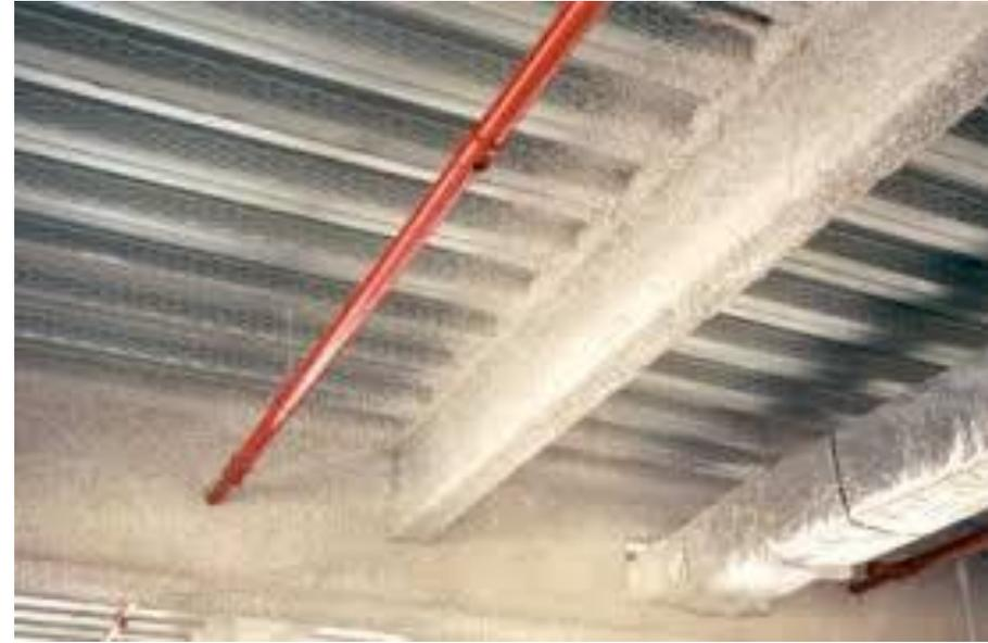
Aplicação de proteção passiva contra fogo com o uso de material a base de vermiculita.
