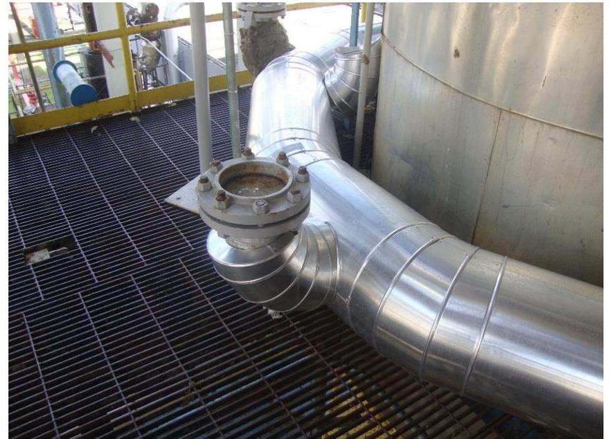
Substituição de isolamento térmico-convencional por Isolamento em Jaquetas. (Facilidade de Manutenção)
