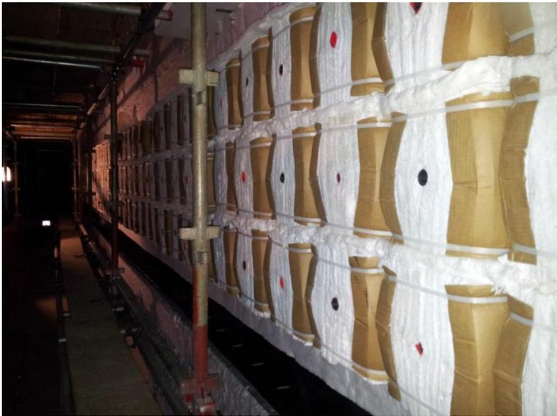
Aplicação de módulos de fibra cerâmica nas paredes internas da radiação dos fornos.
