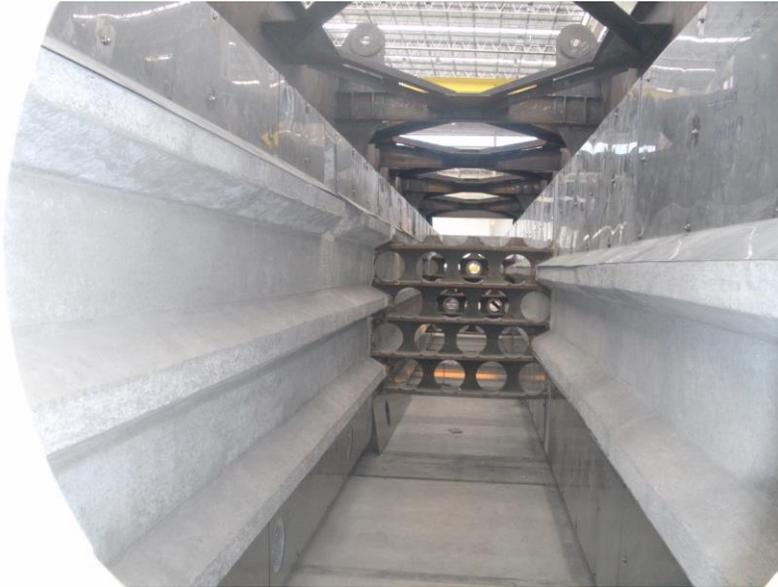
Paredes laterais da convecção, revestida com concreto refratário classe B. (RNEST)
