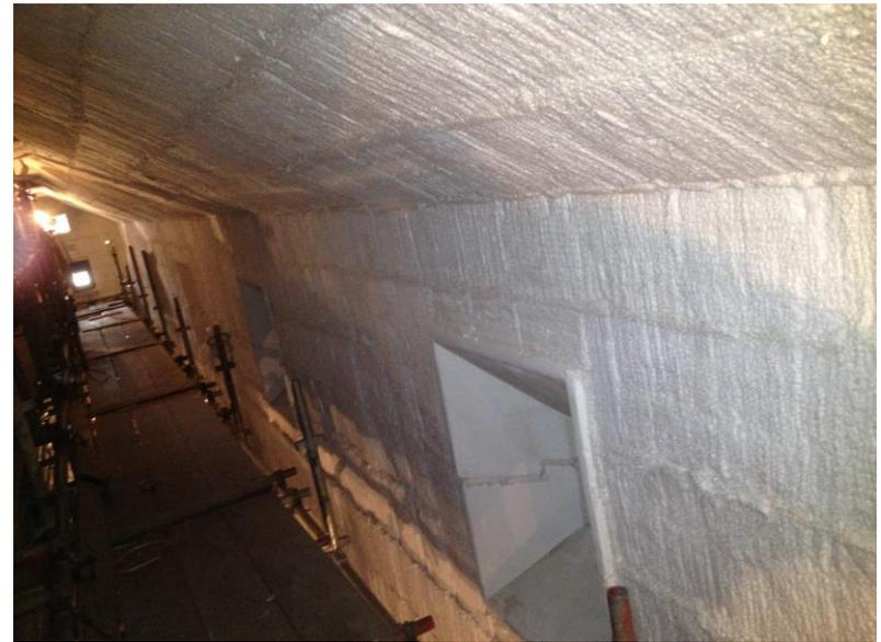
Aplicação de módulos de fibra cerâmica nas paredes internas e teto inclinado da radiação de fornos “Tipo Caixa e Cabine”.
