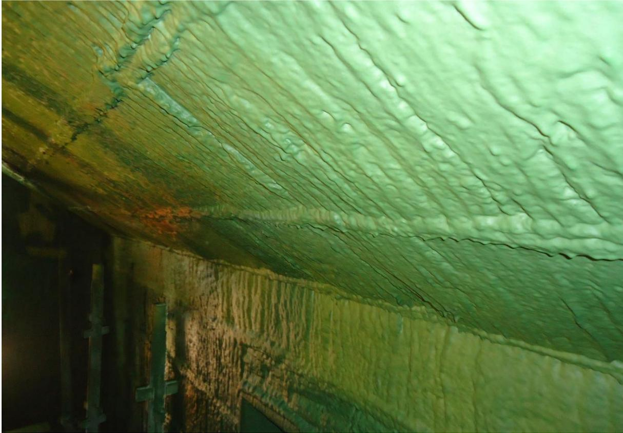
Aplicação de cimento **COAT** a base de cromo nas superfícies dos módulos de fibra cerâmica nas paredes internas da radiação em fornos cilíndricos. (RNEST)
