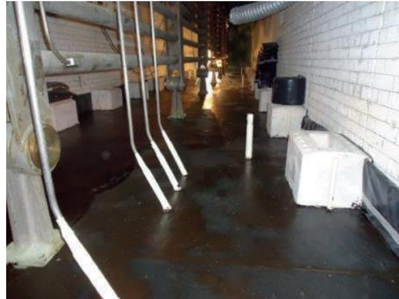
Piso da radiação do forno “tipo cabine”, revestido em sua primeira camada com massa anticorrosiva (emulsão asfáltica).
