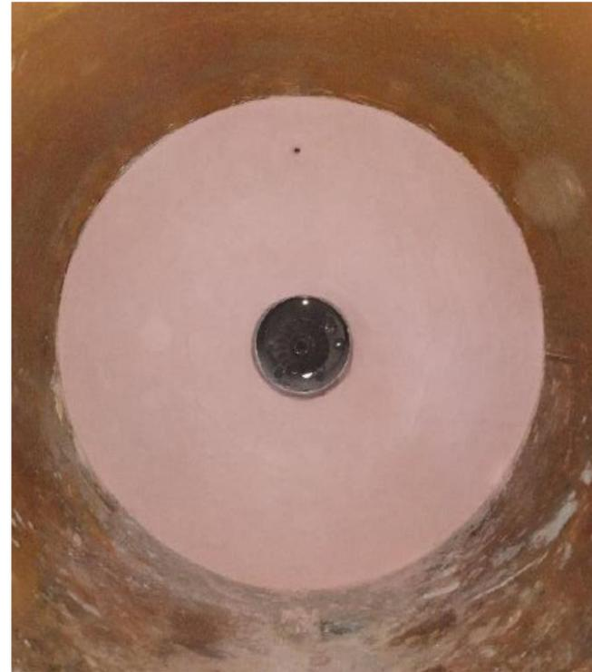
Recuperação do revestimento com aplicação de concreto refratário de pega química THERMOBOND FÓRMULA 6 P
