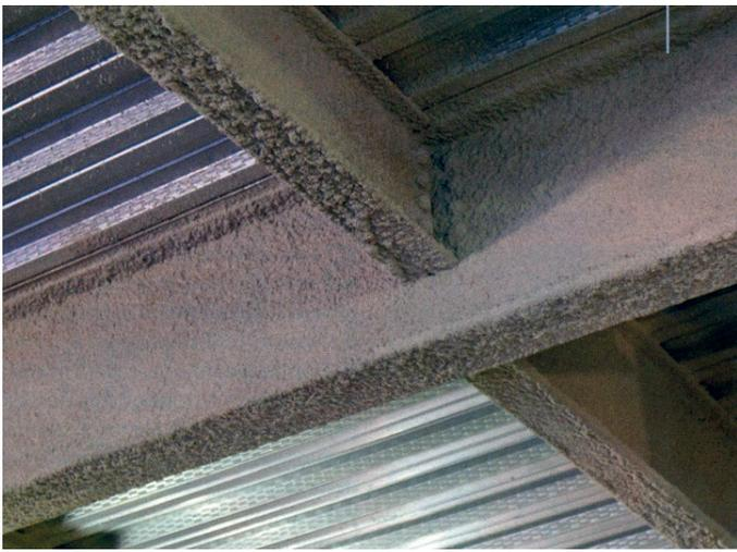
Aplicação de proteção passiva contra fogo com o uso de flocos de fibra cerâmica.
