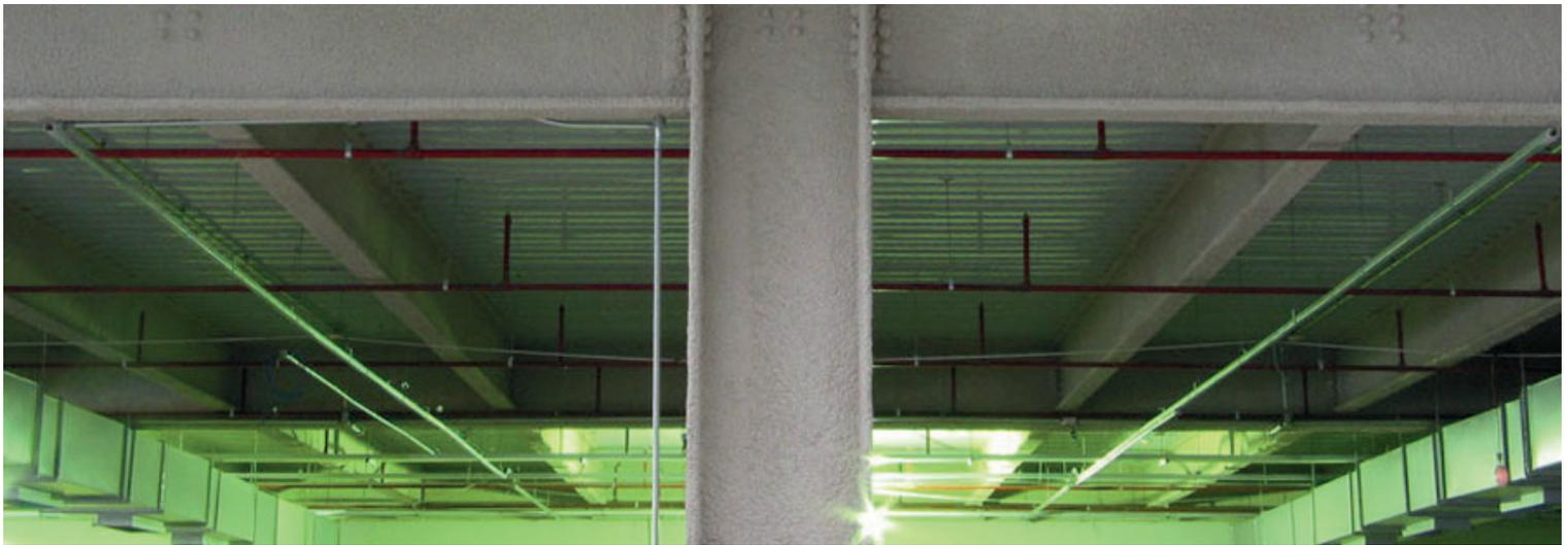
Aplicação de proteção passiva contra fogo em estrutura perfil “I” com a utilização de tinta intumescente.
