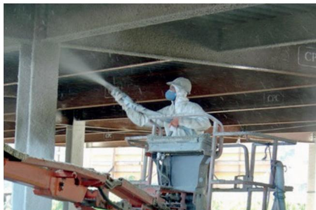
Aplicação de proteção passiva contra fogo com o uso de concreto refratário projetado.
