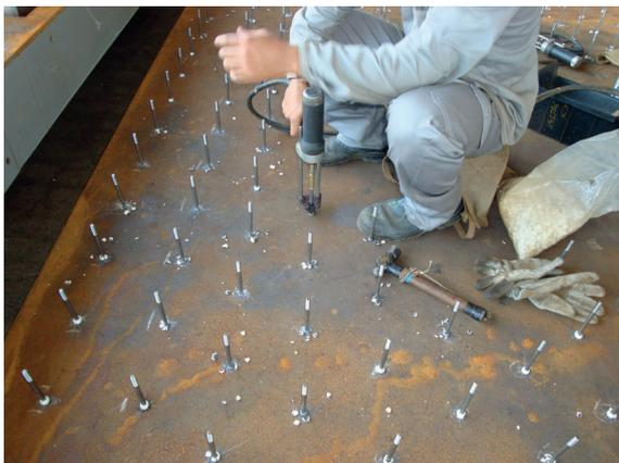
Processo de soldagem Stud Welding de grampos de ancoragens.
