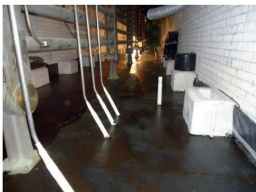
Piso da radiação do forno “tipo cabine”, revestido em sua primeira com massa anticorrosiva (emulsão asfáltica).
