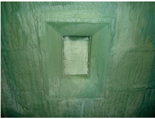
Aplicação de cimento coating a base de cromo nas superfícies dos módulos de fibra cerâmica nas regiões dos visores de chama das paredes internas da radiação em fornos.
