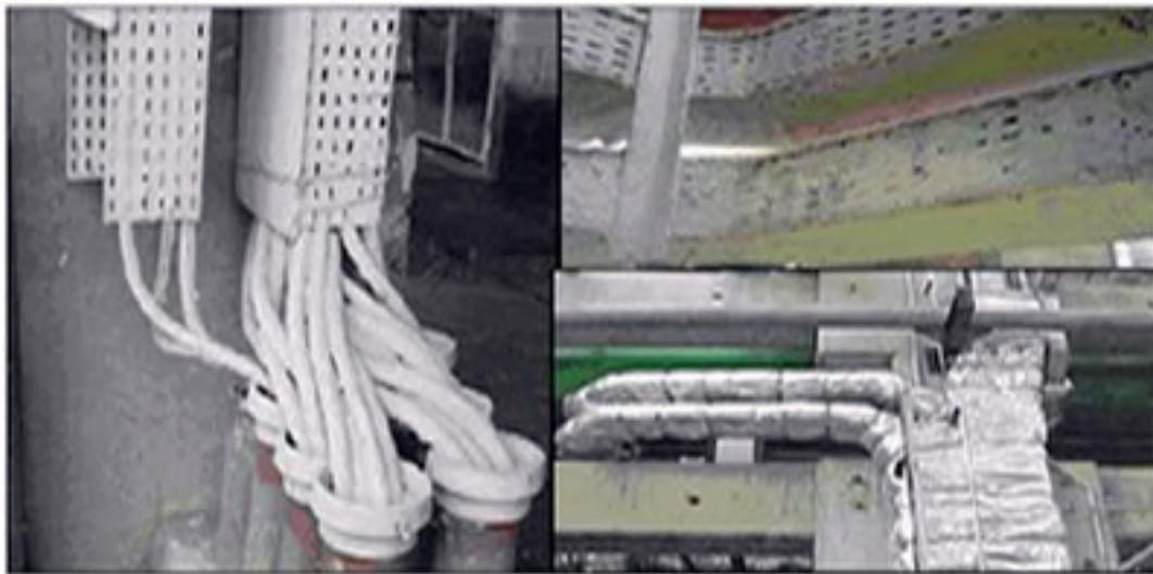
Aplicação de proteção passiva contra fogo com o uso de tinta intumescente e manta fibra cerâmica encapsulada.
