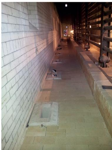
Parede e piso da radiação de forno “Tipo cabine double fire”, revestido com tijolos isolantes (parede) e tijolos densos nas áreas do piso, altar e blocos queimadores.
