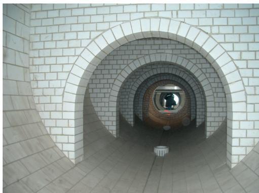
Parede do forno “Tipo Túnel”, revestido com tijolos refratários com alto teor de alumina.
